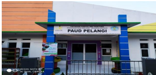
Pintu Masuk Sekolah PAUD Pelangi
